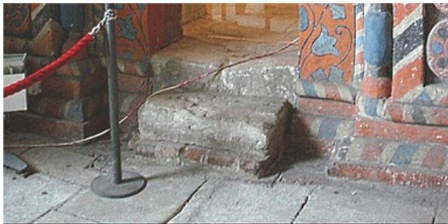
Фото 79 к рис.104. Разница в уровнях полов придела и площадки с южной стороны Западной башни и составляет 37см. Коричневые кирпичи поверхности площадки, «подлезают» под первый слой кирпича в основании башни. «Облом» в цокольной части обрамления портала виден полностью
