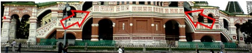
Фото 81. Контрфорсы и аркбутаны в виде массивных каменных лестниц, которые усилили несущую способность северной и южной стен, служащих основанием для Западной башни
