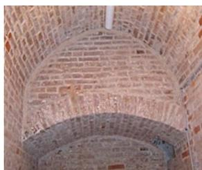
Фото.82. Вид подводного арочного контрфорса в торце длинного помещения западной части подклета
