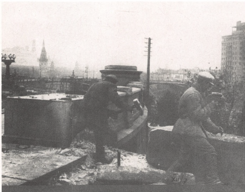
Разборка постамента. Производится подрубка связей, соединяющих гранитные плиты.
