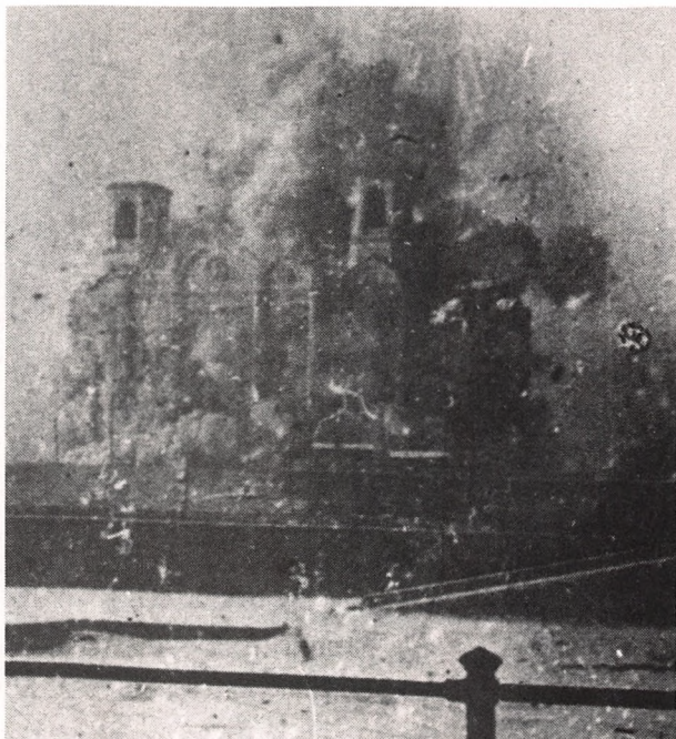
Главный взрыв. Рвут пилоны.
