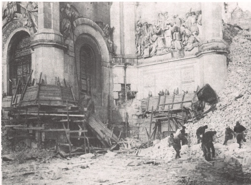
Основной взрыв произведен, видна хорошо сохранившаяся наружная облицовка из Подольского мрамора. Стена подорвана следующей серией взрывов.
