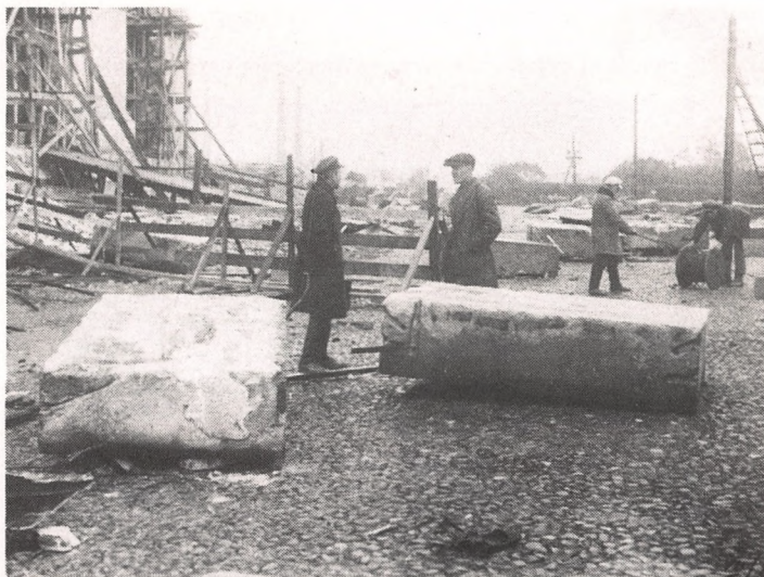
Отдельные глыбы гранита наружной облицовки.
