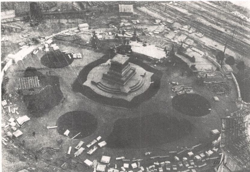
Вид с крыши б/храма. Виден снятый мрамор и катки, при помощи которых происходила выкатка отдельных плит весом 1,5 – 3 т. В центре постамент памятника Александру III, подлежащий разбору.
