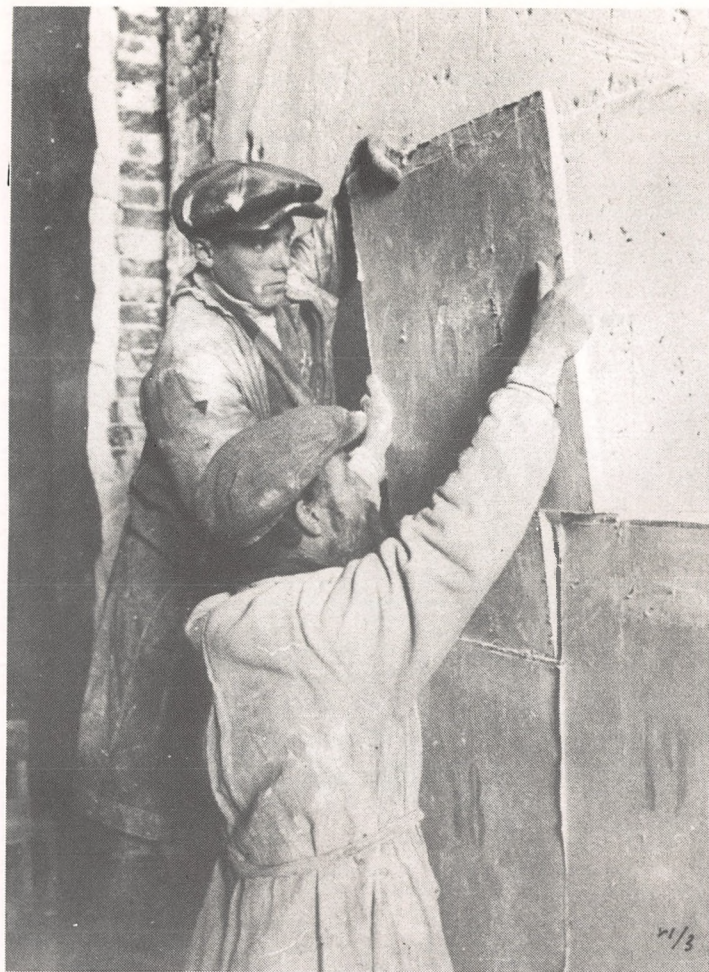
Укладка в ящики спиленных со стены картин. Спиливание картин производилось вместе со слоем штукатурки.
