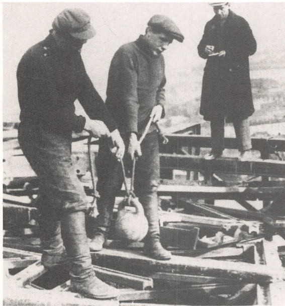
Гирей бьют чугунную решетку перед сбрасыванием вниз и отправкой на завод б. Гужена для переливки в машинные части.
