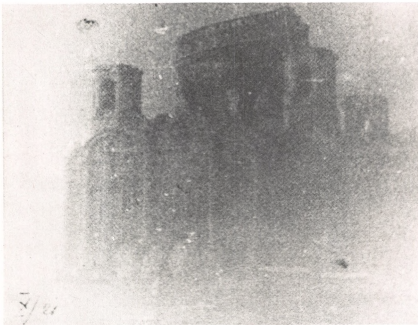
Рвут последовательно два оставшиеся пилона и обрушивается барабан.
