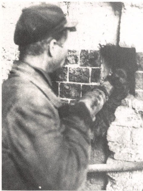
Закладка шпура для помещения зарядов в стенах храма.
