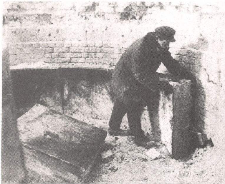
Внутренняя облицовка из массивных плит гранита и мрамора весом до 3 т.
