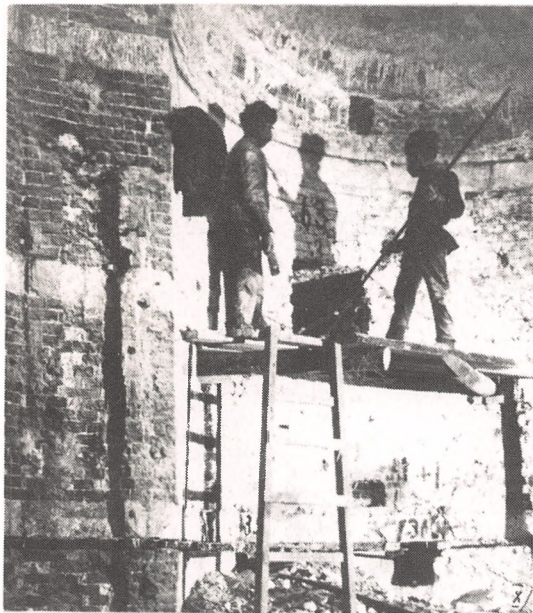
Готовые шпury, выделанные в стенах и пилонах храма. Глубины шпуров от 2 до 5 м. После помещения заряда шпury бетонировались.
