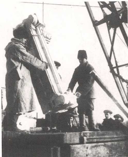
Погрузка мрамора 3-х т. катучим краном на автомобильном ходу. Мрамор грузится на площадке храма для отправки на базисный склад.
