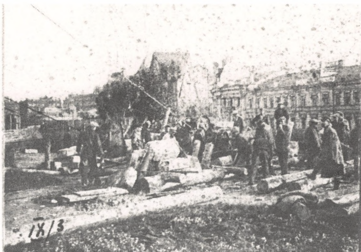
Лебедки, установленные для сбрасывания купола.
