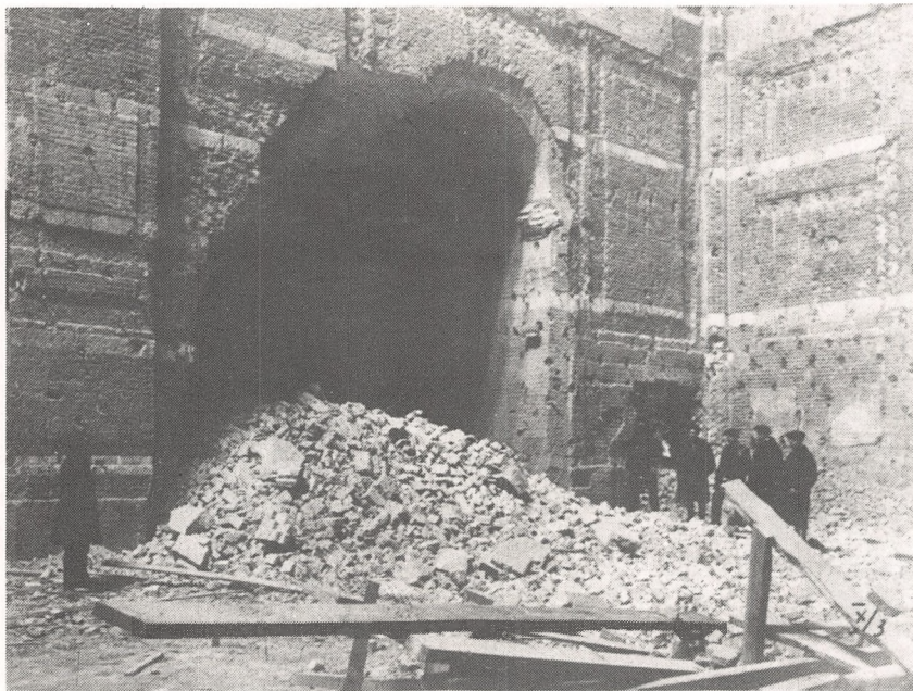
Результат пробного взрыва внутри храма.
