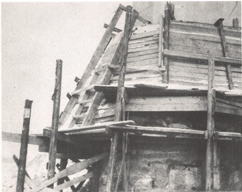
Деталь заградительного барьера, построенного для предупреждения разлета осколков.
