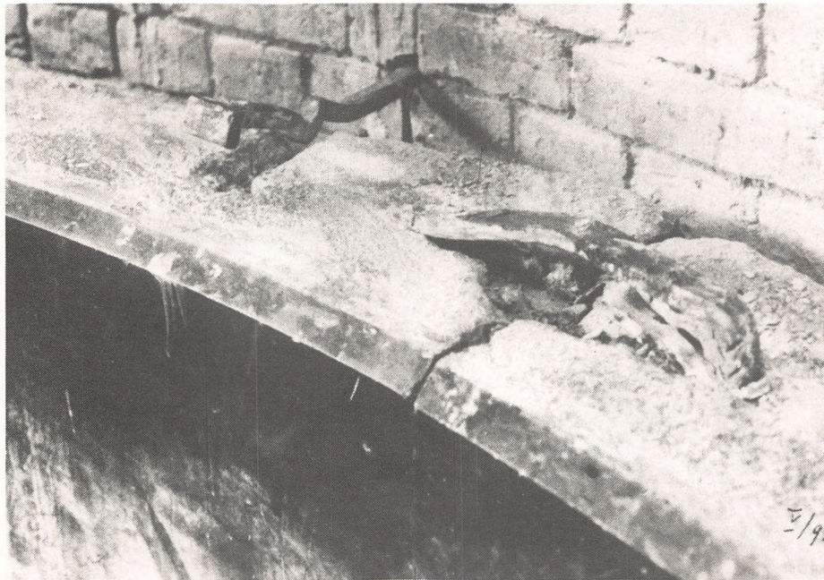
Облицовка залита в швах свинцом и удерживается пероном.
