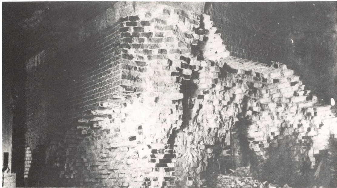
Результат пробного взрыва у пилона. Взрыв был произведен для получения коэффициента, уточняющего вес заряда.
