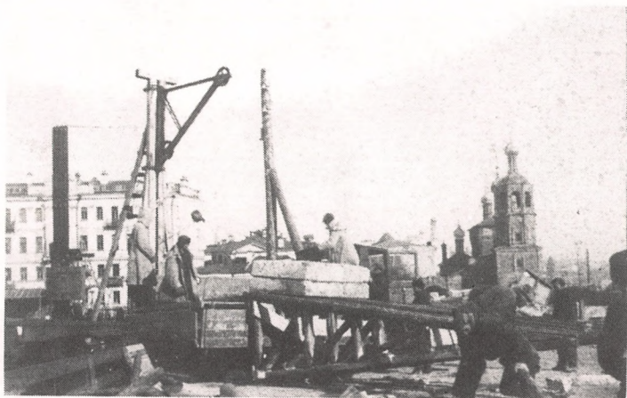
Погрузка снятых плит на автомашину по наклонному упору при помощи краноукосины.
