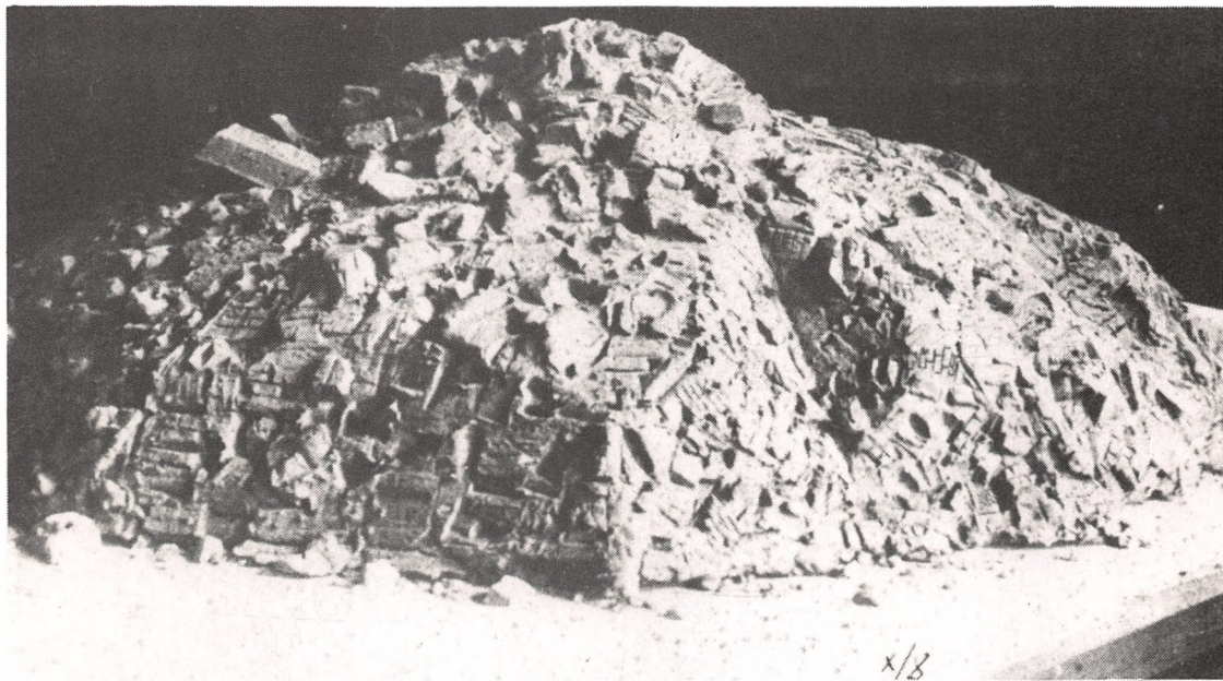
Снимок с макета: куча, которая образуется после взрыва храма. Макет был сделан по проекту И. о. Гл. Инж. Треста проф. Скородумова. После взрыва образовавшаяся куча с макетом совпала.
