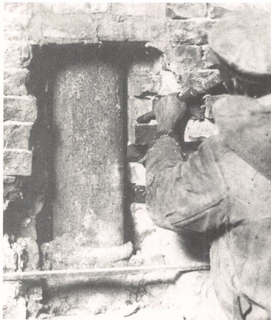
Подготовка к закладке шпуров, в которые будут помещены заряды.
