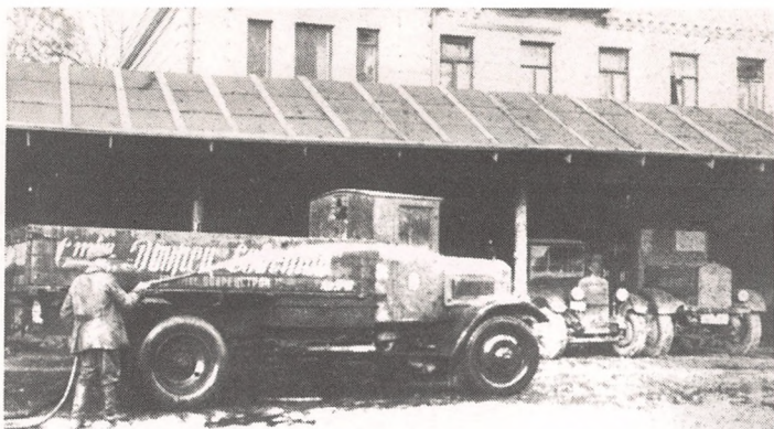
Транспорт строительства Дворца Советов в период подготовки площадки под строительство.
