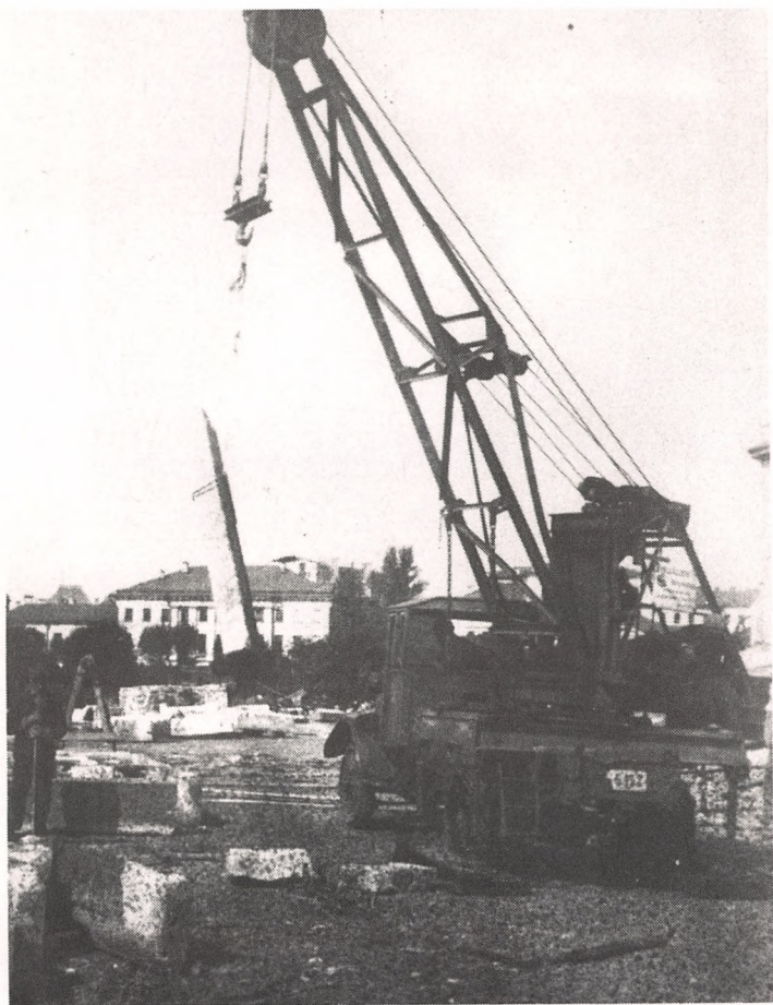
Работа крана укладывающего мраморную облицовку.
