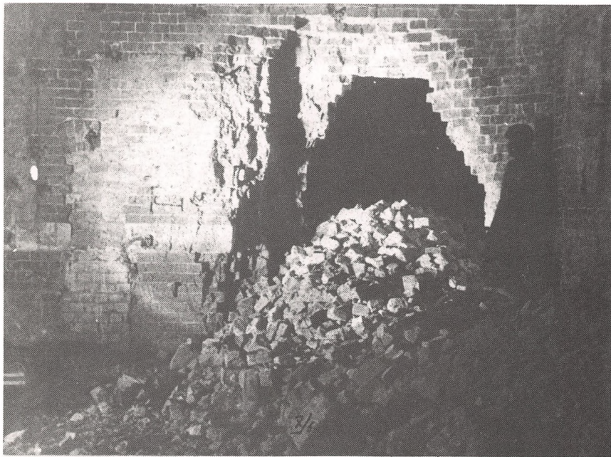
Пробный взрыв, произведенный для определения веса заряда и уточнения расчетного коэффициента.
