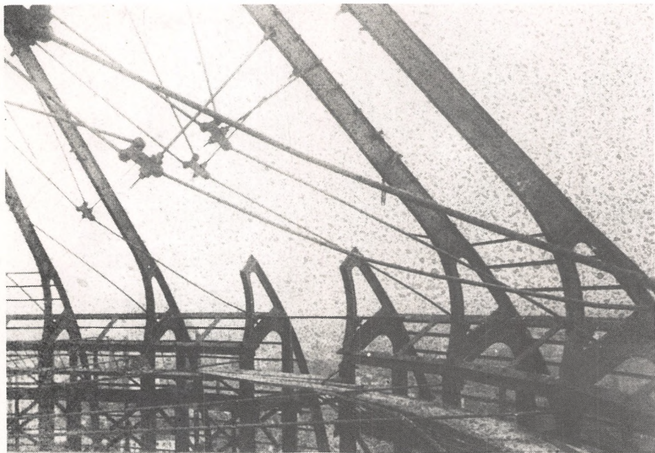
Съемка стальных балок с каркаса главного купола, освобожденных от обрешетки.
