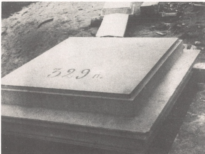
Отдельные гранитные плиты на временном складе.
