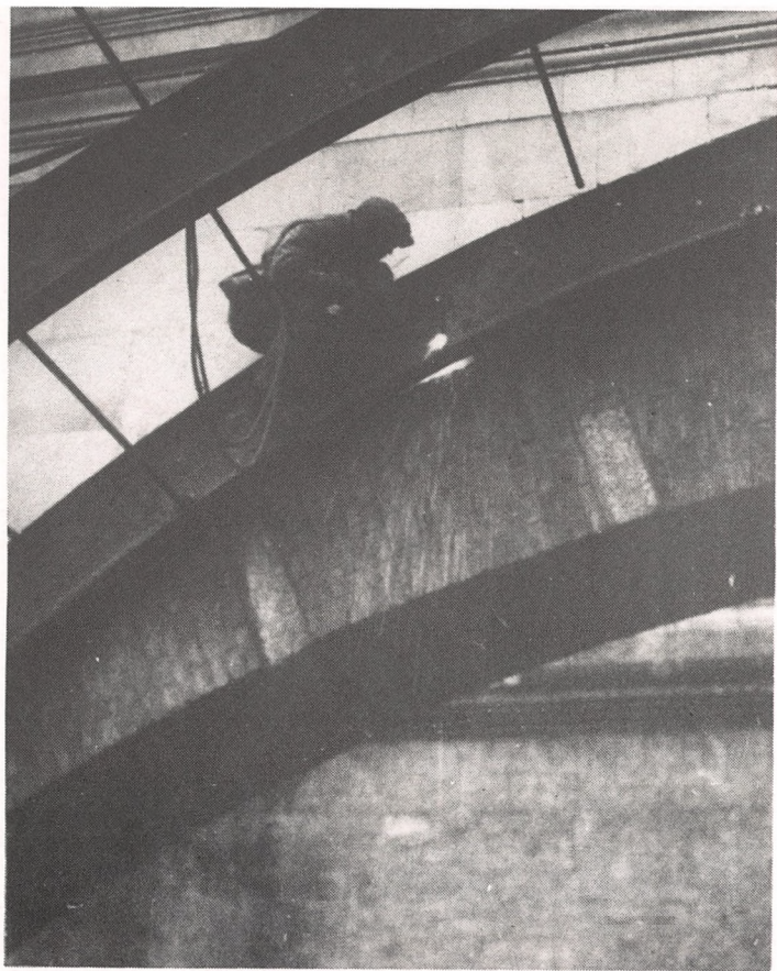
Автогеном режут балки стропил боковых крыльев.
