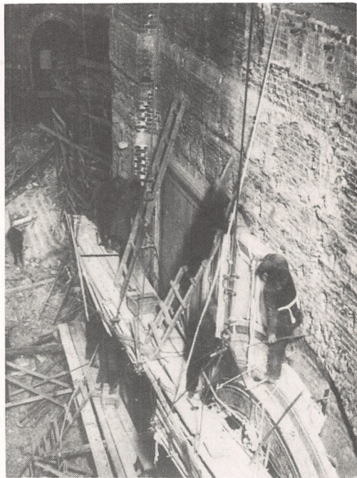
Подрубка облицованных плит, перед спуском вниз. Рабочие стоят на временных подмостях.
