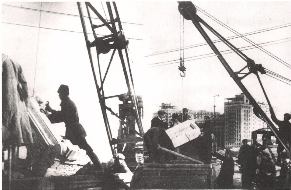
Погрузка мрамора краном на автомобиль. Момент укладки мрамора на платформу автомобиля.
