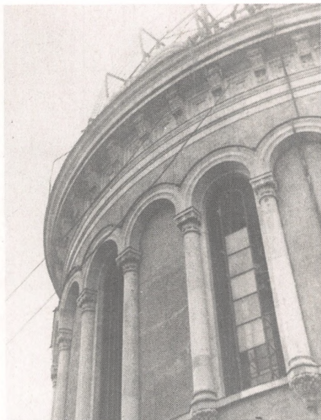
Все снято, сейчас начнут снимать подвесную дорогу, по которой спустили 10 000 пудов металла.
