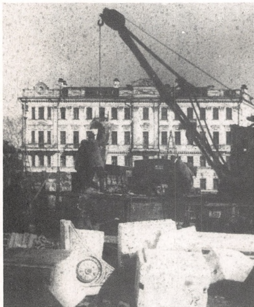
Погрузка мрамора 3-х т. катучим краном на автомобильном ходу. Мрамор грузится на площадке храма для отправки на базисный склад.
