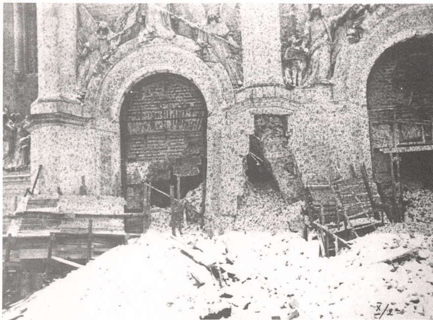
Пробный взрыв снаружи храма, взрыв имел целью установить коэффициент заряда.
