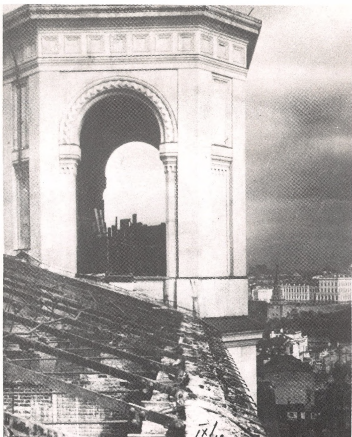
Башня храма без купола, купол сброшен. Видны стропила, перекрывающие чердак.
