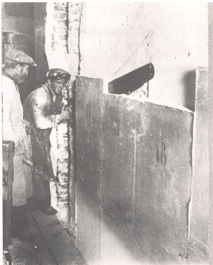
Деталь спиливания картины вместе со штукатуркой. Спиливание производится на галерее храма. Отдельные доски картины пронумерованы для более удобной сборки картины после перевода на холст.
