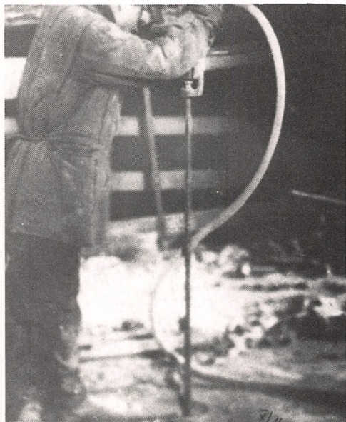
Бурение шпура перфоратором. Шпур закладывается в перекрытие галереи. Взрыв имеет целью установить коэффициент внутренних зарядов.
