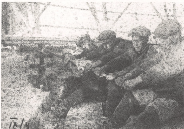
Поднимают домкратом купол для сбрасывания.
