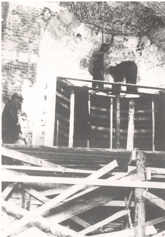
Снимают живопись, заделывая ее вместе со штукатуркой в ящики.
