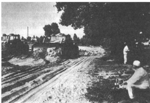
Снятие грунта, зараженного радиоактивностью
