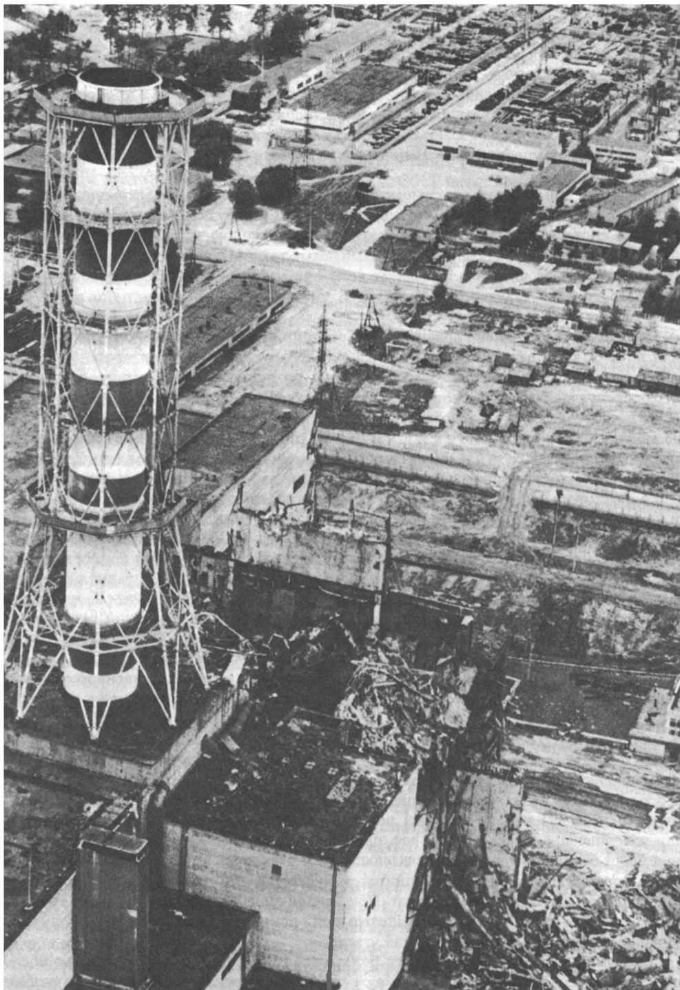
Панорама Чернобыльской АЭС после катастрофы. На переднем плане – разрушенный 4-й блок
